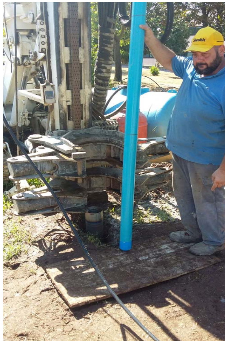
S1 - insimento primo tubo in pvc
