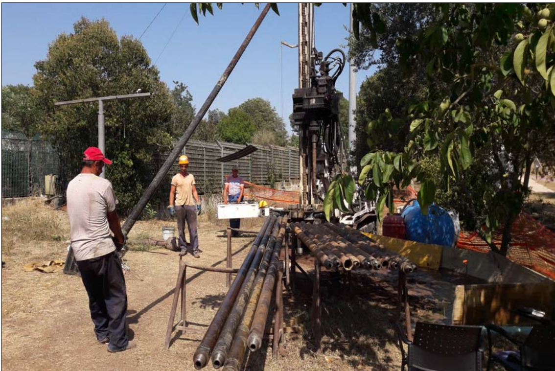
S1 - fase di perforazione
