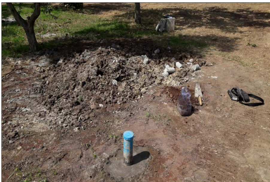
S1 - testa tubo in pvc a fine cementazione
