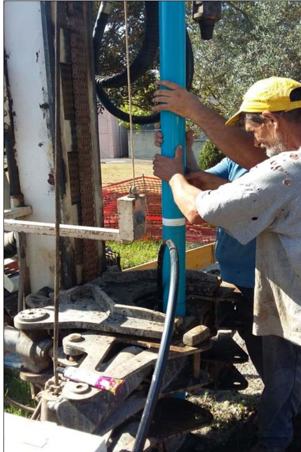
S1 - inserimento tubi in pvc e tubi di iniezione
